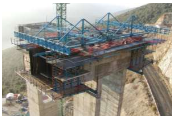
Πρώτη φάση κατασκευής σπονδύλων φορέα
