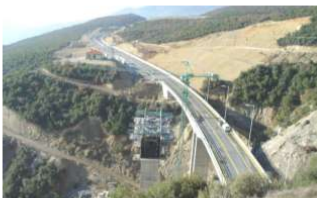
Γέφυρα Γ2: Η κατασκευή του δεξιού κλάδου έχει ολοκληρωθεί. Ο αριστερός κλάδος είναι υπό κατασκευή
