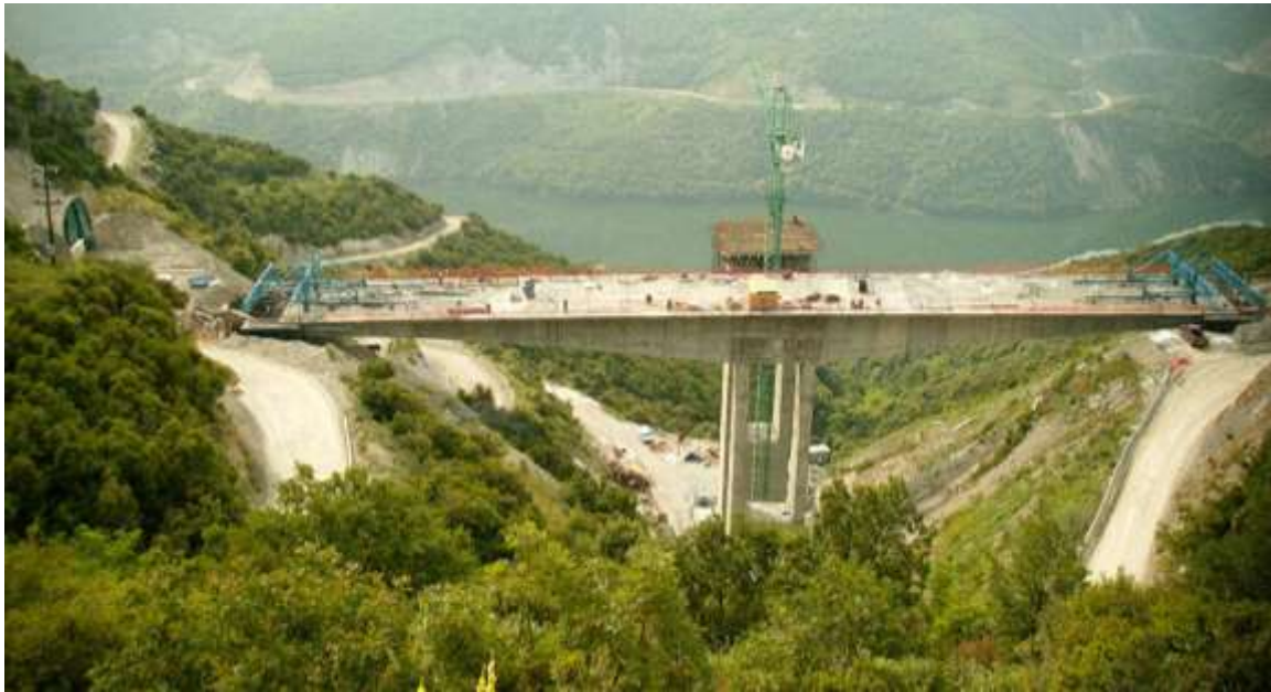
Γέφυρα Γ1: Φάση κατασκευής με δόμηση εν προβόλω
