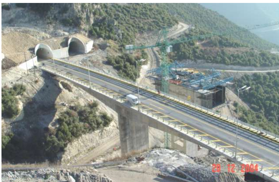
Γέφυρα Γ1: Η κατασκευή του δεξιού κλάδου έχει ολοκληρωθεί. Ο αριστερός κλάδος είναι υπό κατασκευή
